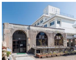
本川小学校 平和資料館 被爆校舎の一角を原爆の証として保存
